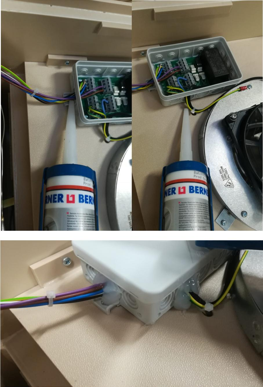
Außerdem Kabeldurchführung vom Tank zum Brutraum auf Dichtigkeit prüfen, gegebenenfalls mit Silikon abdichten.
